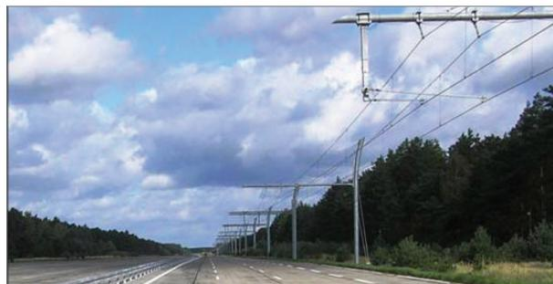
eHighway System의 핵심 기술은 지능화된 팬티그래프 센서와 운영시스템이다. 트럭의 지붕에 있는 지능적인 집전장치 센서는 트럭 상부에 전력선이 있는지를 인식하고, 시간당 최대 90km 범위에서 이 전력선에 자동으로 연결하거나 연결을 끊을 수 있다. 이 시스템은 트럭이 최대 시간당 90km의 속도로 다른 트럭을 추월하도록 차로를 변경할 수 있게 한다. 만약 전력선이 사용되면 트럭은 어떠한 배출가스도 만들지 않는다. 통상적인 다른 도로에서는 설치된 구동 시스템에 따라 디젤, 천연가스, 배터리 전기 등으로 에너지원을 다양하게 변경할 수 있다.
