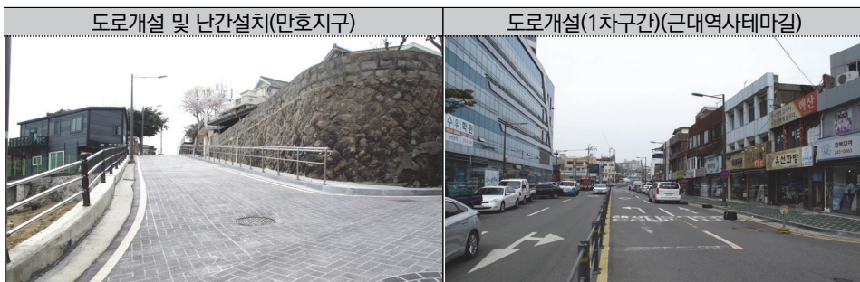
그림 부-4 | 목포시 근대역사테마길 및 만호지구 도화사업 현장사진
